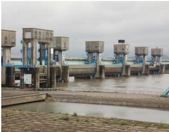
筑後大堰ゲート全開状況 (上流側から下流を望む) 平成23年6月21日9時撮影
