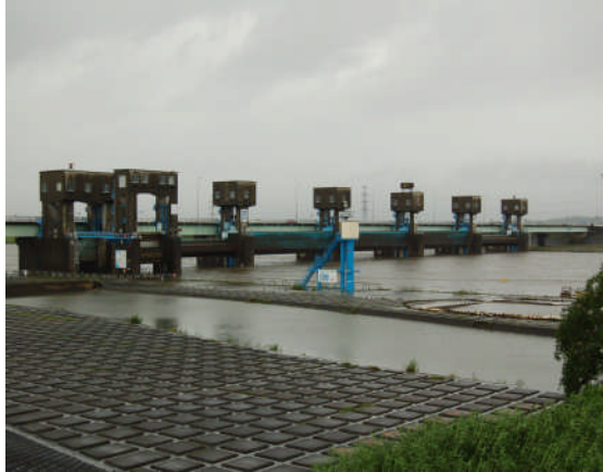
筑後大堰ゲート全開状況 (上流側から下流を望む) 平成23年7月7日8時撮影
