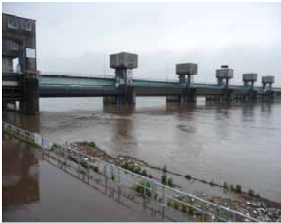
筑後大堰ゲート状況 （上流側から下流を望む） 平成24年7月2日6時撮影
