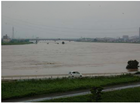
堰直上流状況(7月14日11時撮影)
