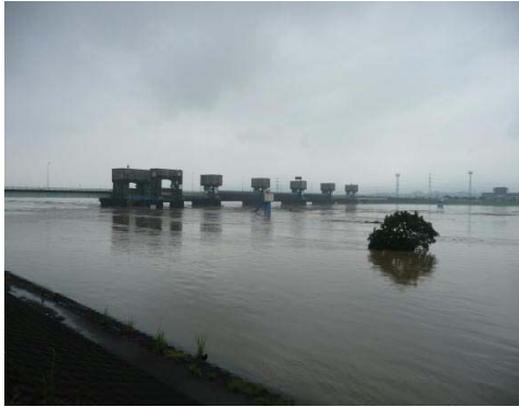
筑後大堰ゲート状況(7月14日11時撮影) (上流側から下流を望む)
