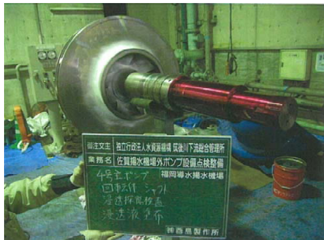
ポンプ軸等の非破壊検査状況（参考）
