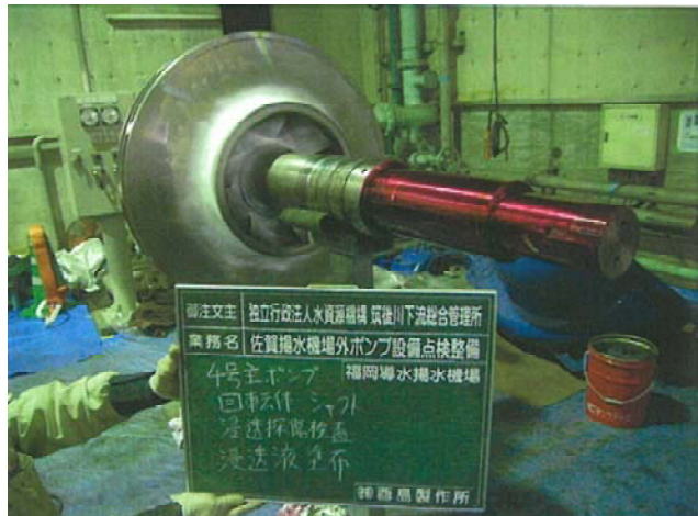
ポンプ軸等の非破壊検査状況（参考）
