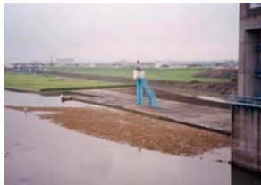
開門前面に溜まったゴミにより船の通航・魚道操作に支障
