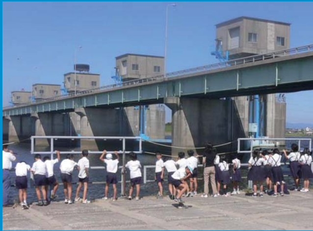
「筑後大堰で学ぶ、筑後川とのつながり」
