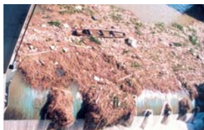
ゲートの開閉に支障
