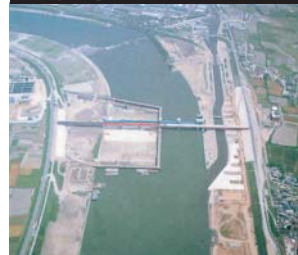
3期工事（昭和57年10月～昭和58年5月）
