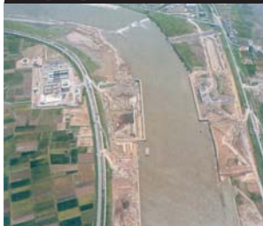
1期工事（昭和55年12月～昭和56年9月）
