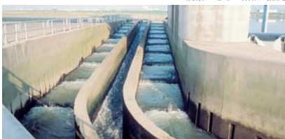
干潮のときの階段式魚道
