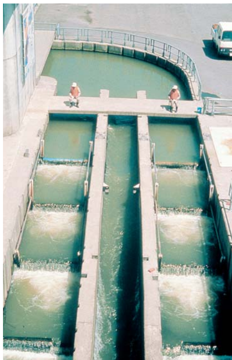
階段式魚道での目視調査
