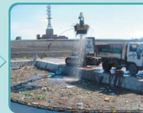
② 重機によるゴミ陸上げ
