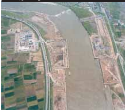
1期工事 (昭和55年12月～昭和56年9月)
