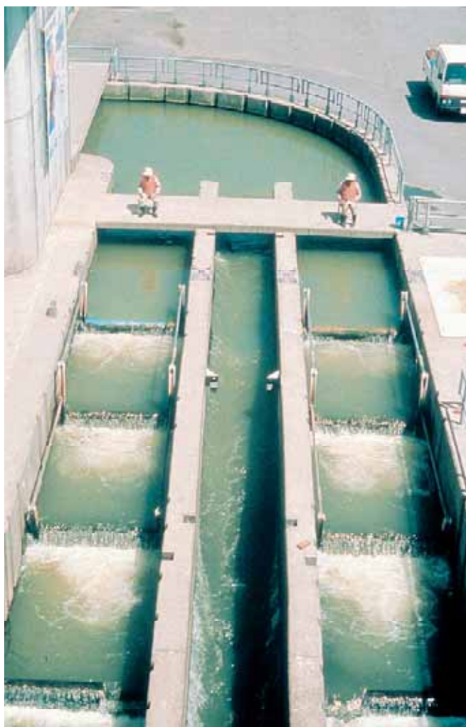
階段式魚道での目視調査
