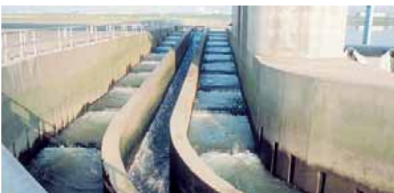
干潮のときの階段式魚道
