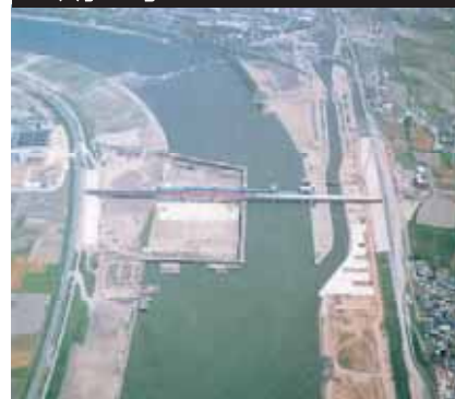
3期工事 (昭和57年10月～昭和58年5月)
