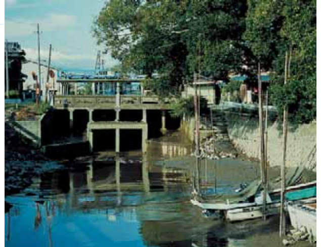
旧淡水取水樋門
