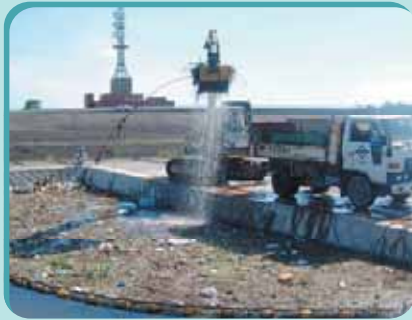
② 重機によるゴミ陸上げ
