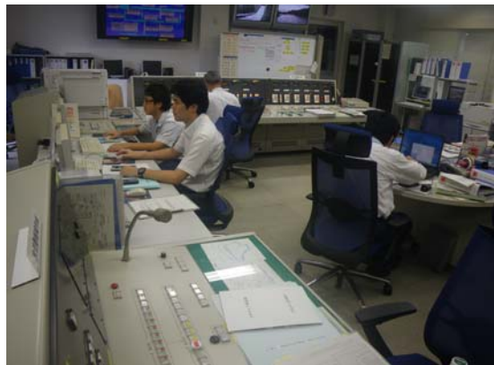
洪水調節の操作状況
