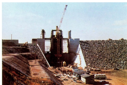
洪水吐(流入部)建設状況 (S51.11)
