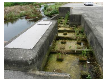
小田頭首工魚道(無水状態)
