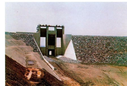
洪水吐(流入部)建設状況 (S52.3)
