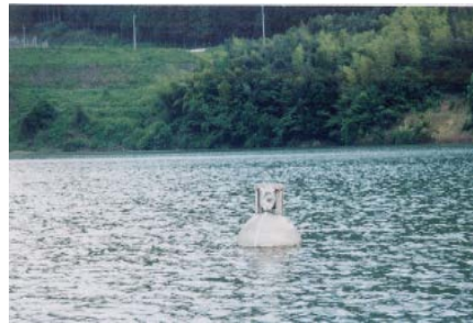
気泡式循環設備(H11～、H15～)
