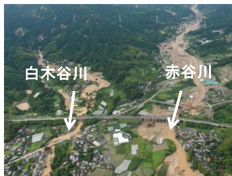
河道埋塞の状況(白木谷川・赤谷川)
