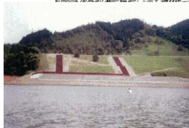
荷原地区土砂流入防止工(H8～)
