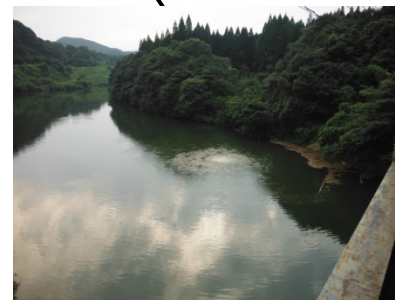
気泡式循環設備(H23～)
