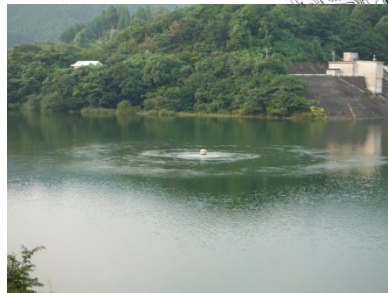
気泡式循環設備(H23～)
