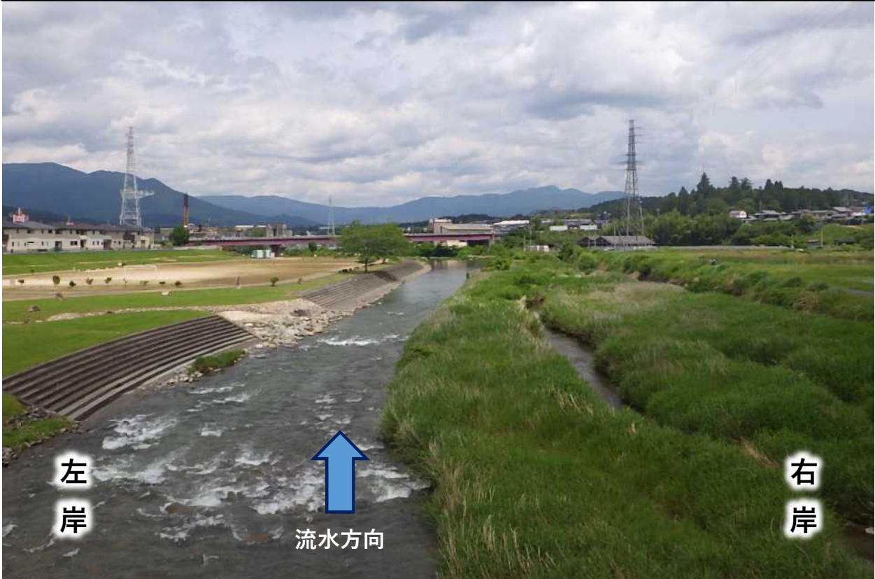
阿木川公園 現地写真（洪水前）（令和5年6月1日10時35分頃撮影）
