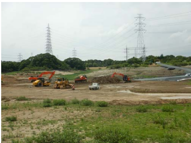
掘削・造成状況
