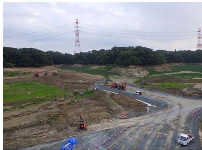
掘削・造成状況
