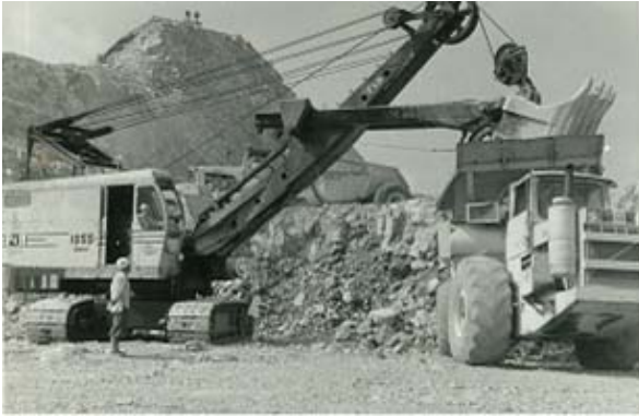
写真-3 1055型クレーン
