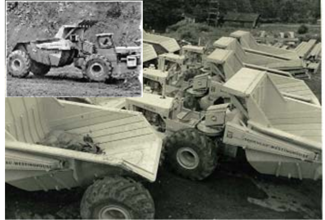
写真-4 22t ダンプホーラ
