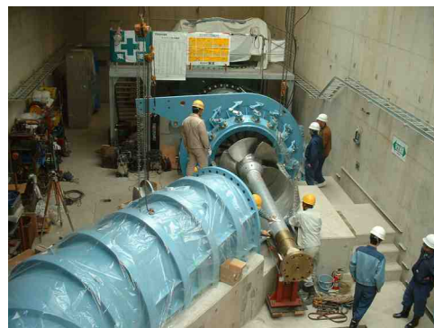
建設中の小水力発電施設
