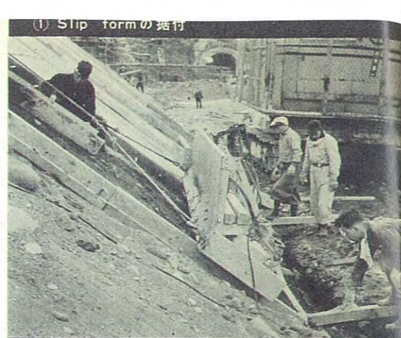
② 打設 — バイブレーター3台使用
