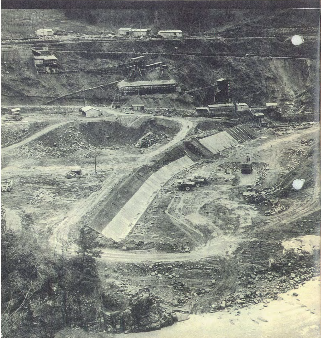
バイパス出口付近の施工状況 第1号バイパス 延長 421m 第2号バイパス 延長 429m
