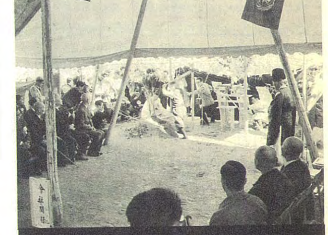
(33. 3. 13) 幹線水路中最大の工事である兼見トンネルの掘入式は、好天に恵まれて幸先のよいスタートを切った
