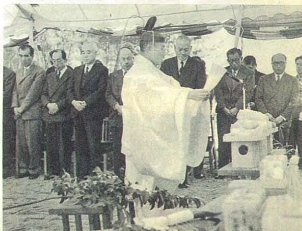
(32. 12. 2) 待望の着工第1陣として曲り池ダム工事着手。記念すべき掘入式が三好村のダム現場で行われた
