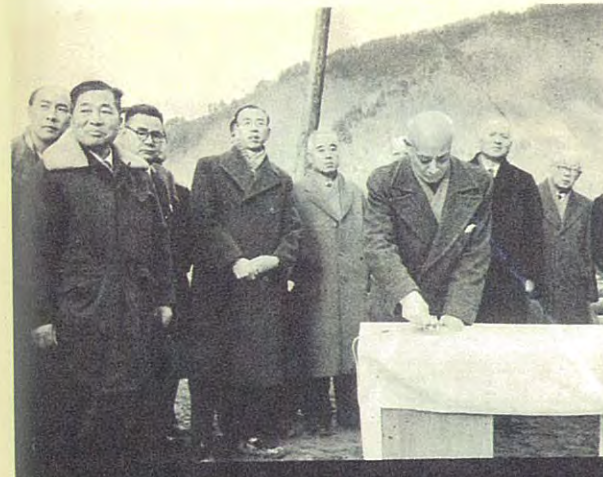
(32. 12. 21) 続いて第2陣牧尾ダムバイパス工事着手。写真はダム現場の掘入式で発破第1号のスイッチを押す浜口総裁
