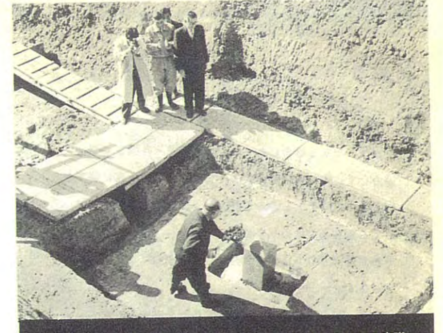
(33. 2. 11) 曲り池ダム定礎式挙行、浜口総裁の筆になる定礎石は森平第1水路所長の手で中心部に堅固に据えられた
