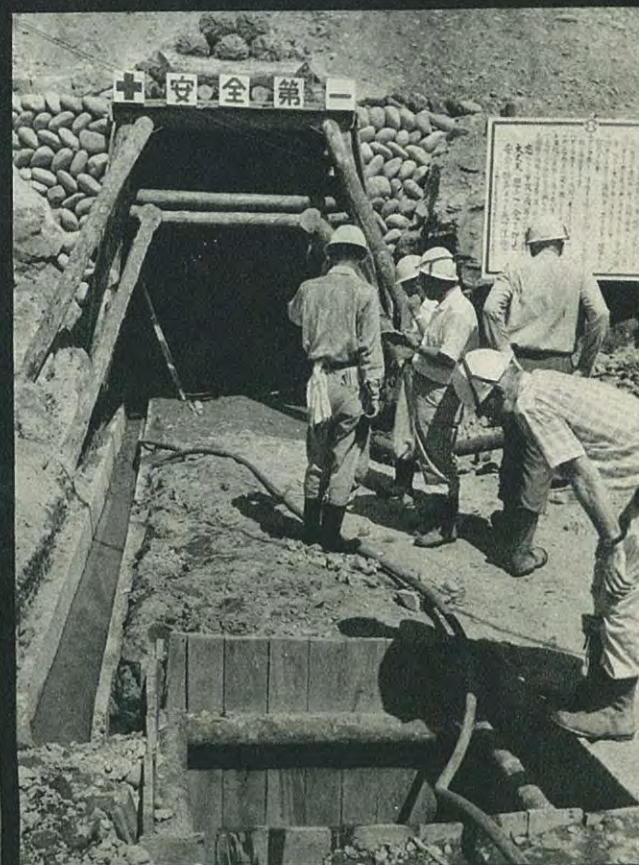
出口、導坑入口であるが、ここは砂礫層で湧水も多く施工最も困難な区間
