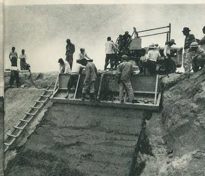
フォームを移動させつつ打設
