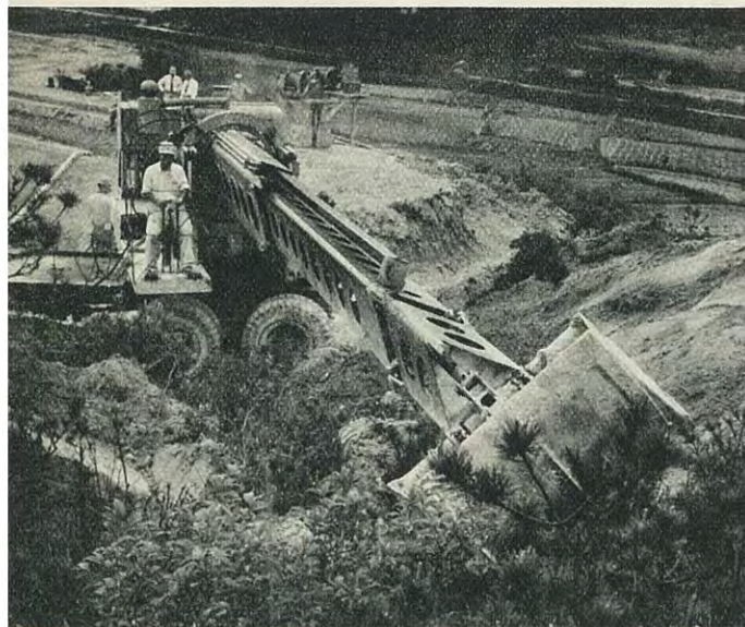
グレードールで表土剥取
