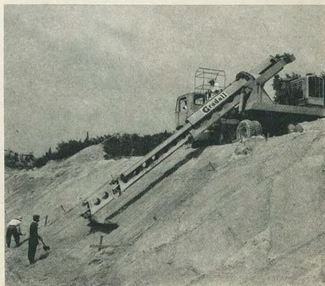
グレードールで法面の仕上げ
