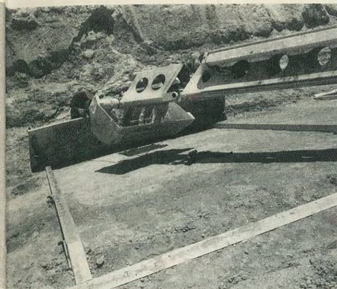
スロープ・フォームの据付
