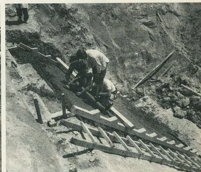
打設おわって面の仕上げ
