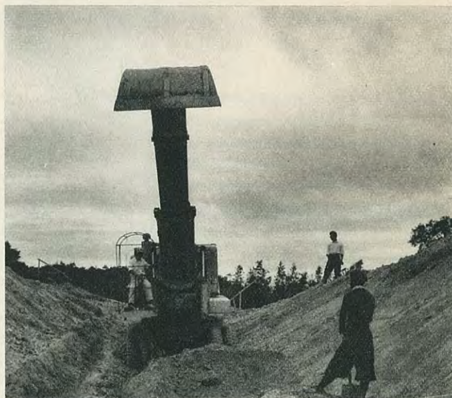
大体設計断面に掘削
