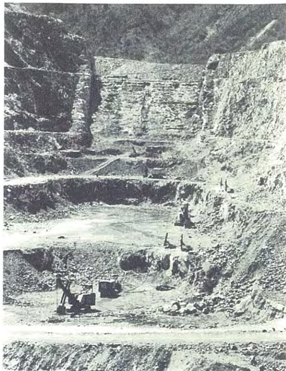
下流部正面からみた余水吐
