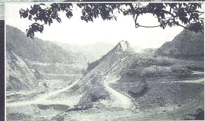
▶ 34年夏、仮締切ダムを完成した当時の牧尾ダム
