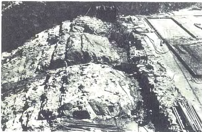
掘削を終った余水吐の溢流堤頂部
