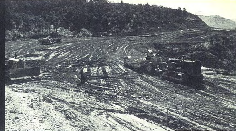
▲まず路盤を締め固める、一見道路工事のようだが……
