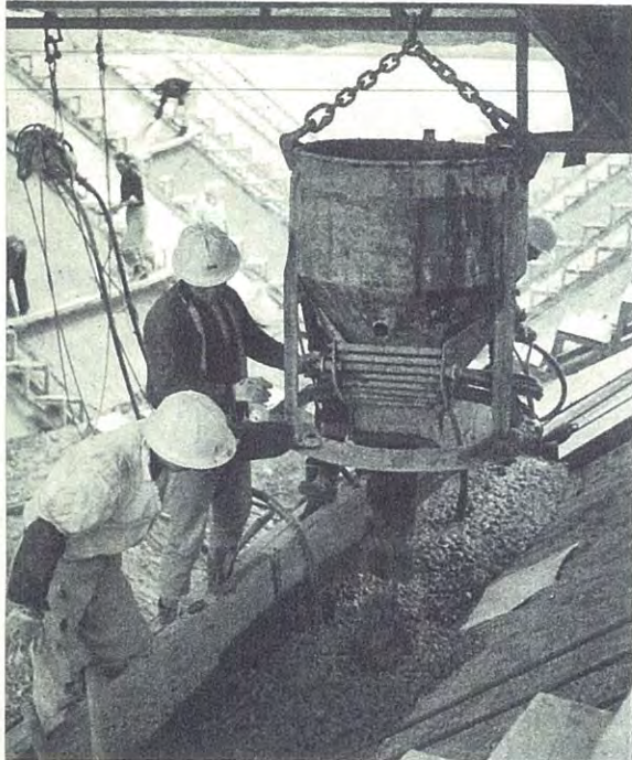
▲上昇するスロープフォームにコンクリートを流し込んでゆく
