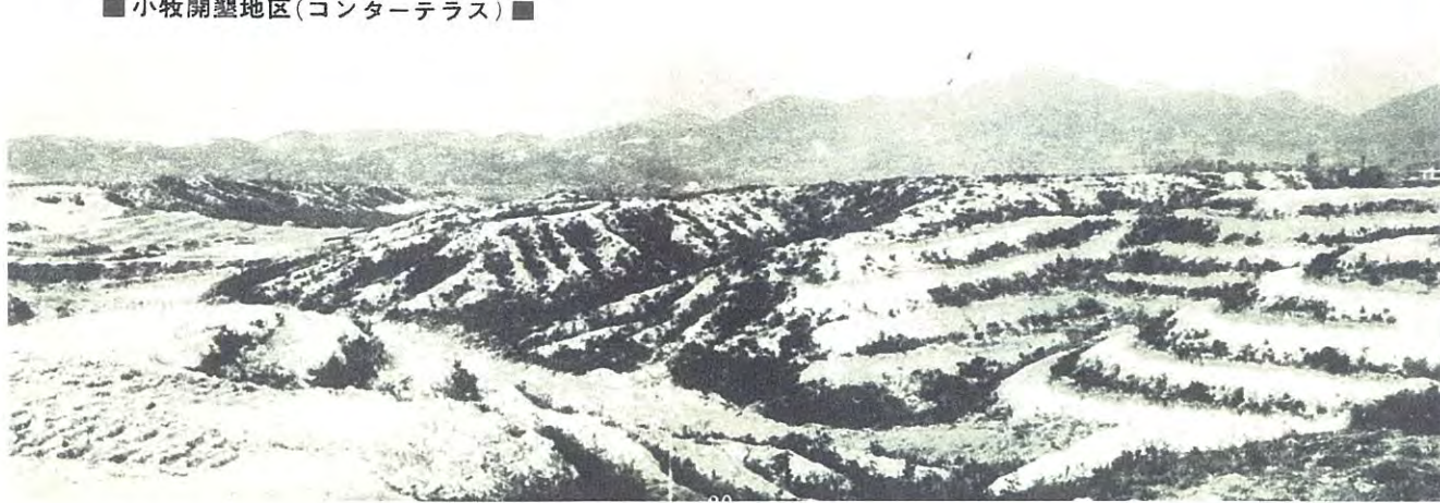
■ 小牧開墾地区(コンターテラス) ■
