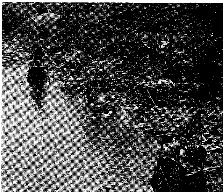
牧尾橋ダム建設地点のボーリング
