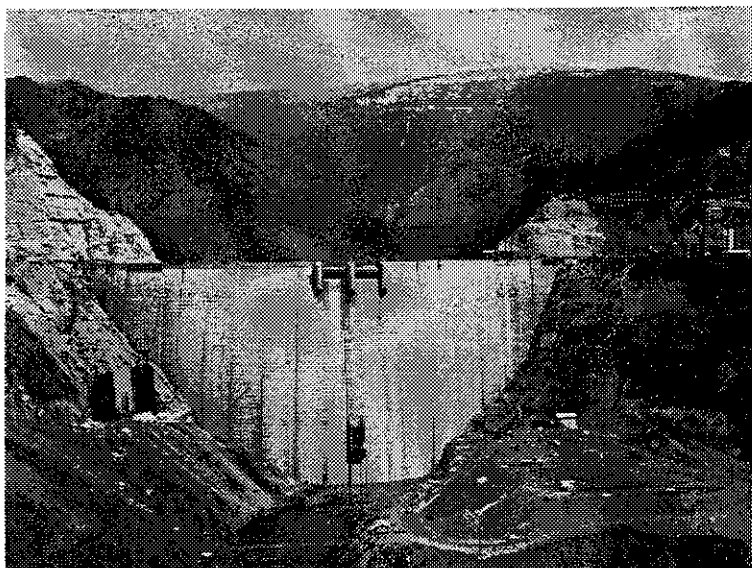
完成間近な高根第1ダム
