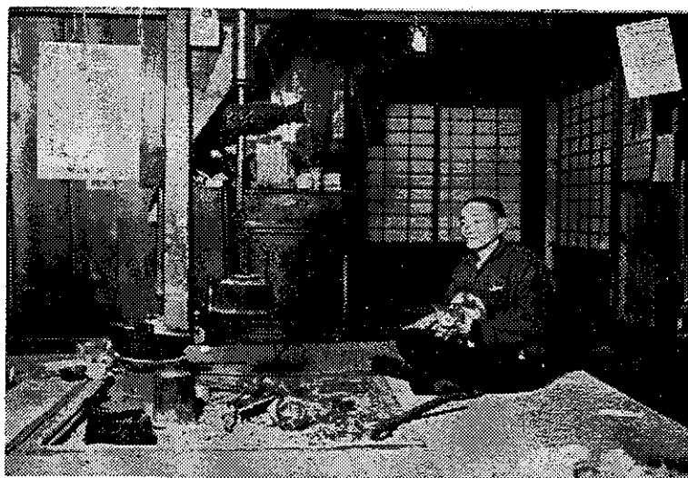
水没家屋の内部
