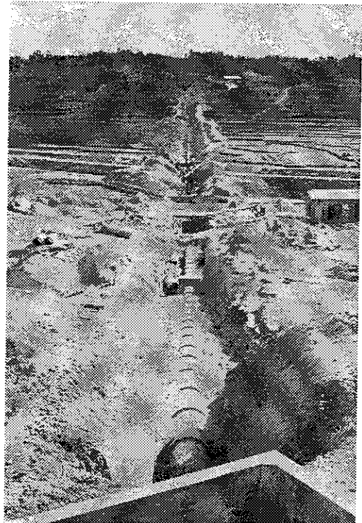
管水路の施工
