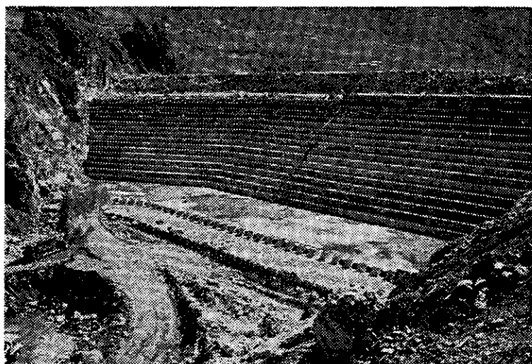
改良復旧した仮締切りダム（下流側）
