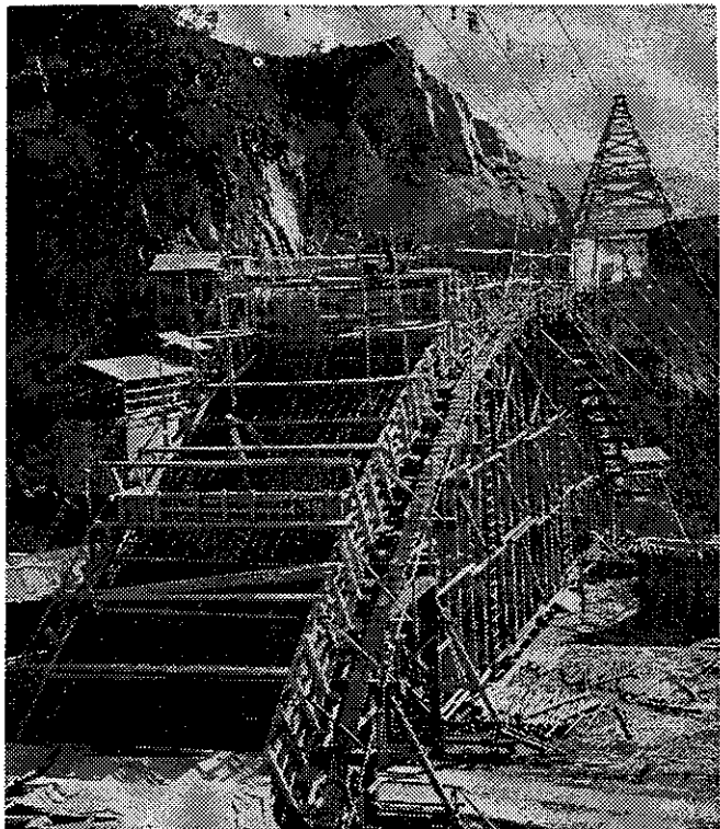
入鹿水路橋の施工
