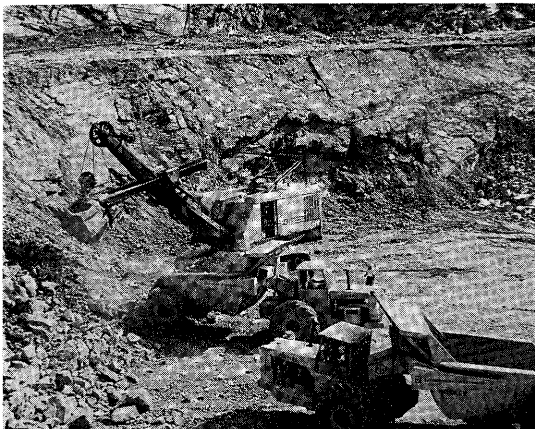
牧尾ダム工事で活躍すパワーショベル（上）とダンプホーラー（下）
