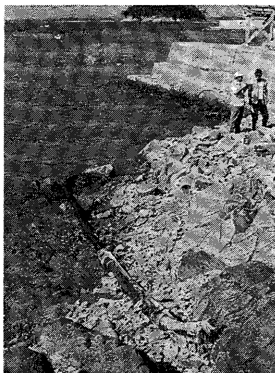
篠島に上陸した海底送水管 (南知多町役場提供)
