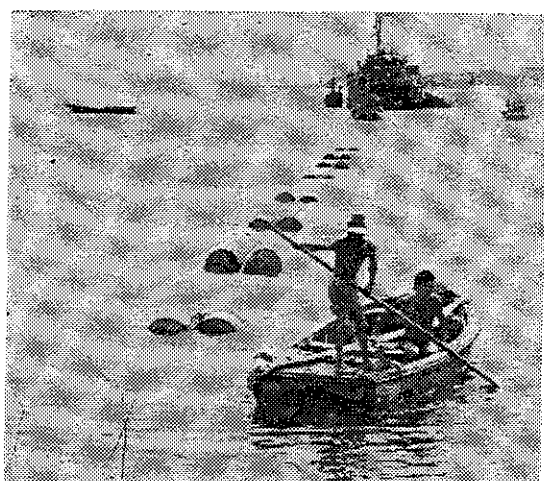
海底送水管の布設作業 (南知多町役場提供)
