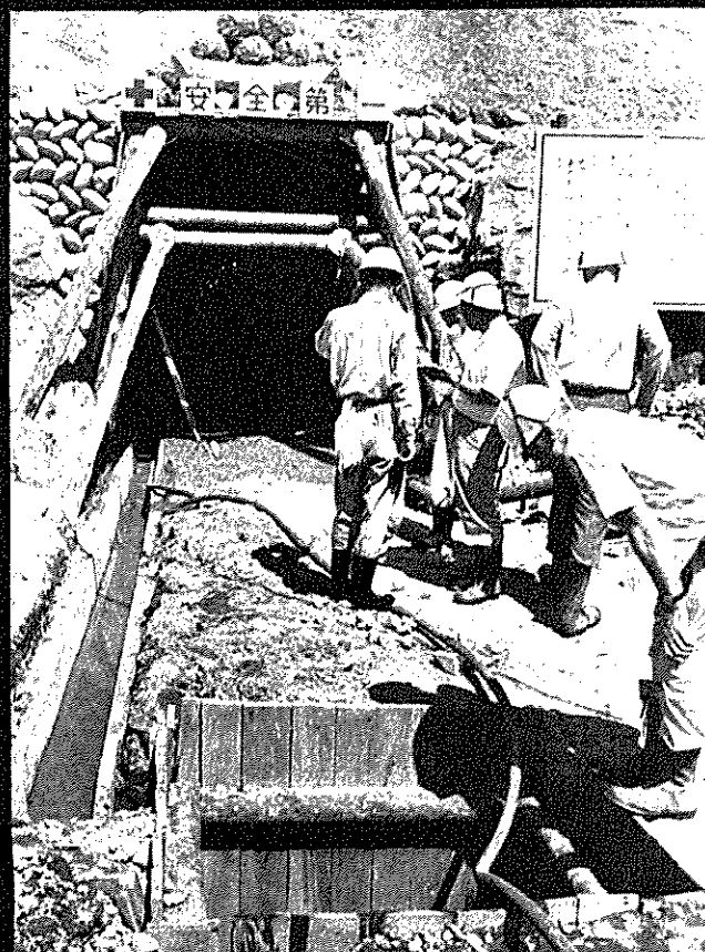
出口、溝坑入口であるが、ここは砂礫層で湧水も多く施工費も困難な区間
