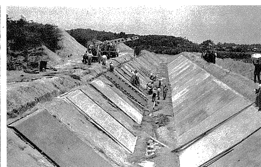
テスト工事全景(コンクリート面はビニール溶液を吹付け養生中)
