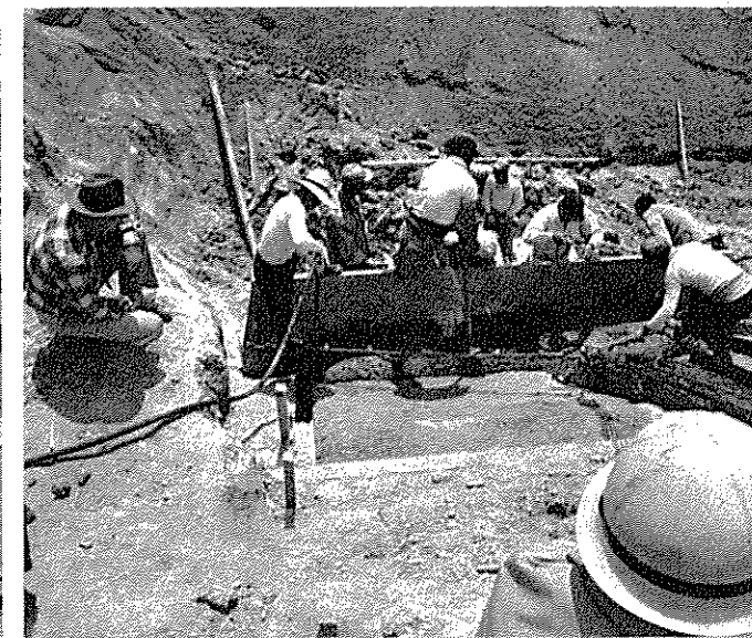
移動ミキサーからコンクリート投入
