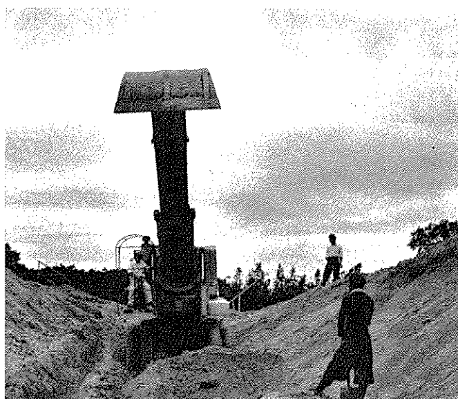
大体設計断面に掘削
