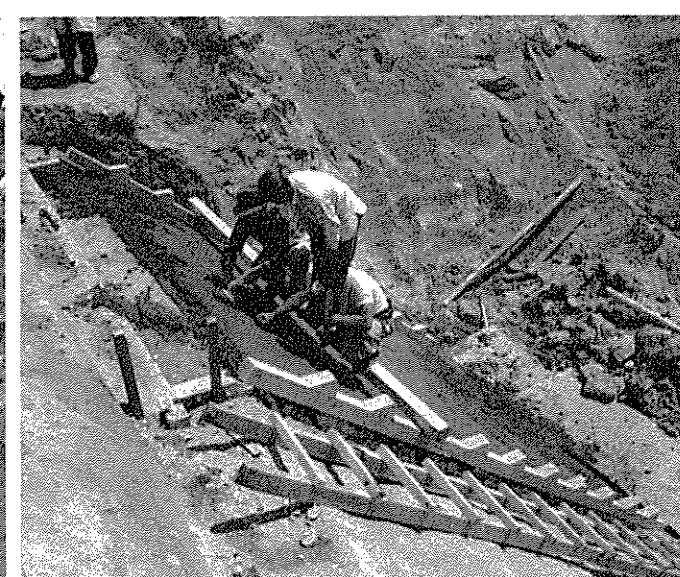
打設おわって面の仕上げ
