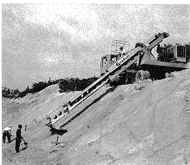
グレードールで法面の仕上げ
