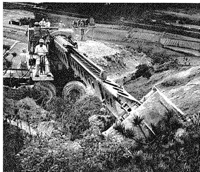
グレードールで表土剥取
