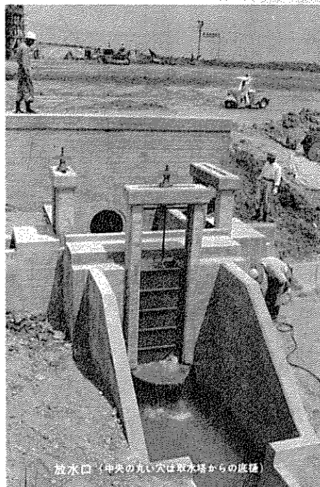
ダムの下流側法面に設けられた放水路（樋は底樋）
