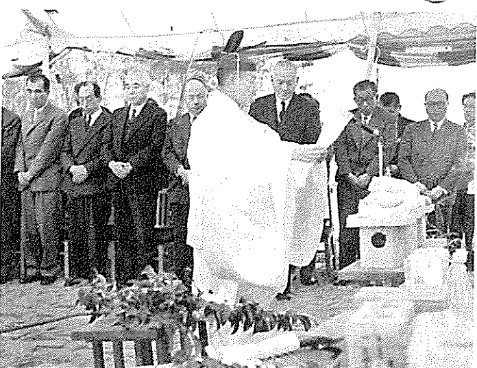
(32. 12. 2) 待望の着工第1陣として曲り池ダム工事着手。記念すべき鉄入式が三好村のダム現場で行われた
