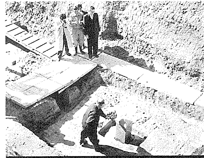
(33. 2. 11) 曲り池ダム定礎式挙行、浜口総裁の聲になる定礎石は森平第1水路所長の手で中心部に堅固に据えられた
