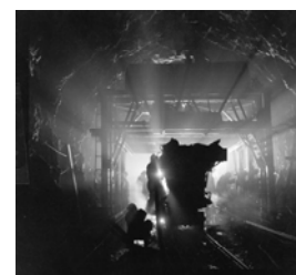
工事中の兼見トンネル
