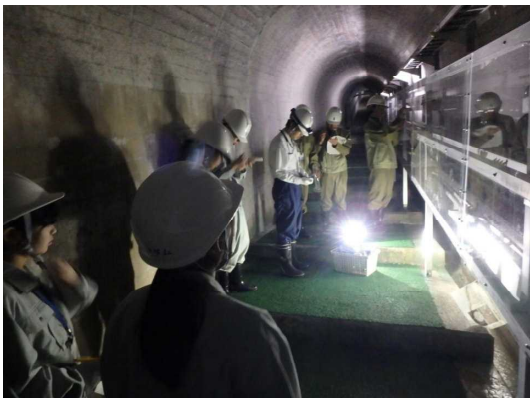
■阿木川堤体の観測状況
