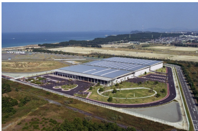
出典:福岡地区水道企業団海水淡水化センター(まみずピア)
