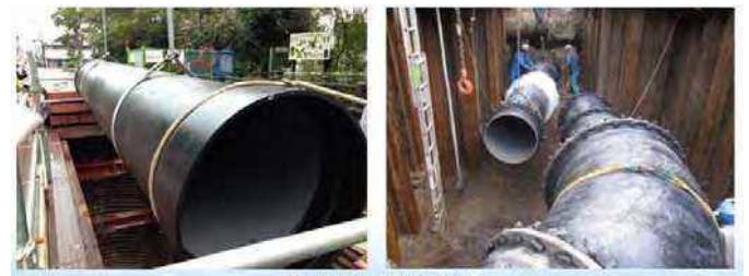
基幹管路の耐震化工事
