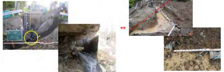
導・送水管破損の事例
