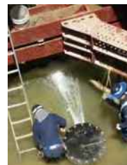
配水管破損の事例
