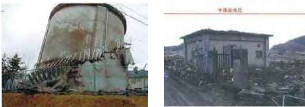
水道施設被害の事例 (左：配水池、右：水源地(浅井戸))
