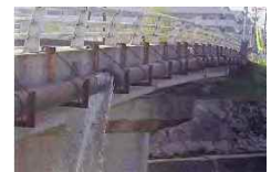
水管橋破損の事例
