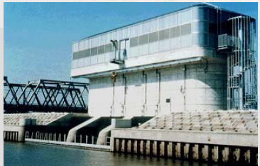
▲長良導水取水口
