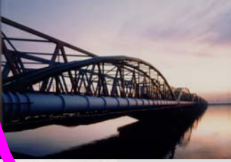
木曽川水管橋▲
