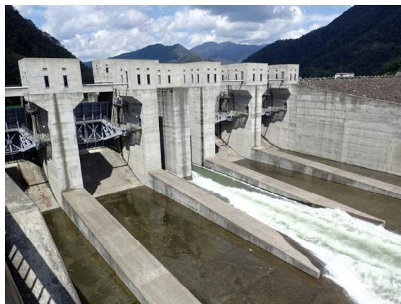
洪水調節で貯めた水を洪水吐きから排水 (9月5日12時頃)
