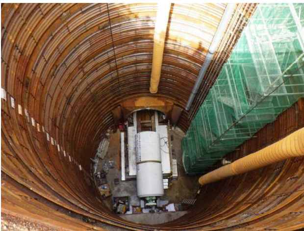
【写真左】 シールドマシン本体を立坑内に設置した時の様子
