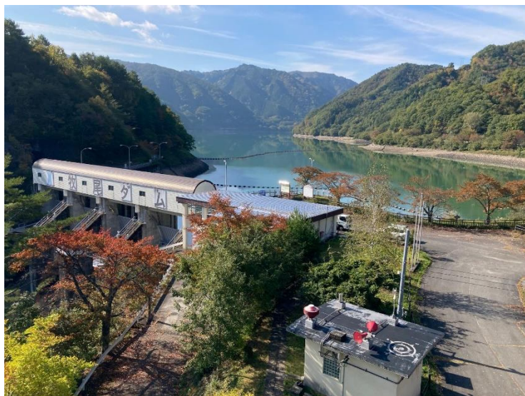
■牧尾ダム全景
