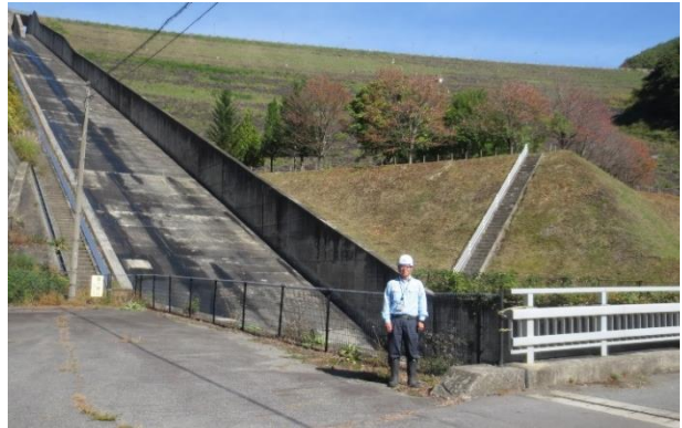
■堤体洪水吐をバックにて
