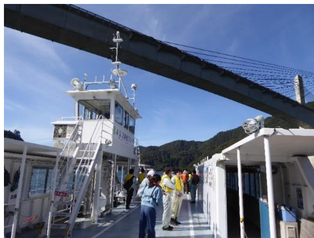
■貯水池横断橋「徳之山八徳橋」を下から
