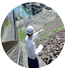
■堤体点検の様子
