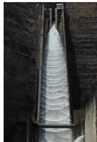
■ゲート点検放流の様子
