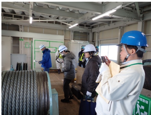
■大堰ゲート巻き上げ室の視察の様子
