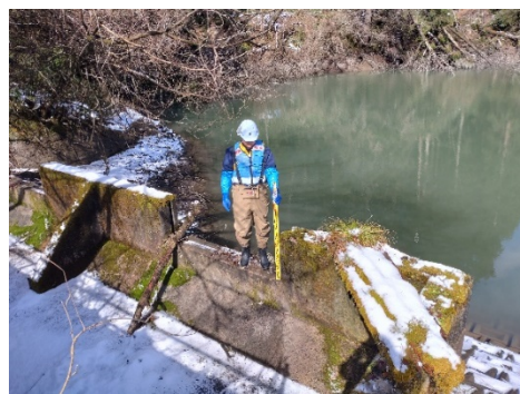
■ため池点検の様子
