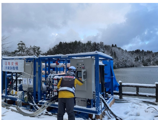
■ 浄水装置点検の様子
