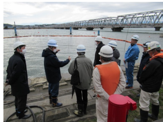
■取水口前の堆積土砂撤去工事の説明の様子
