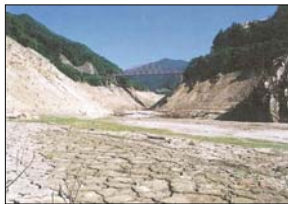
枯渇した岩屋ダム(平成6年8月)
