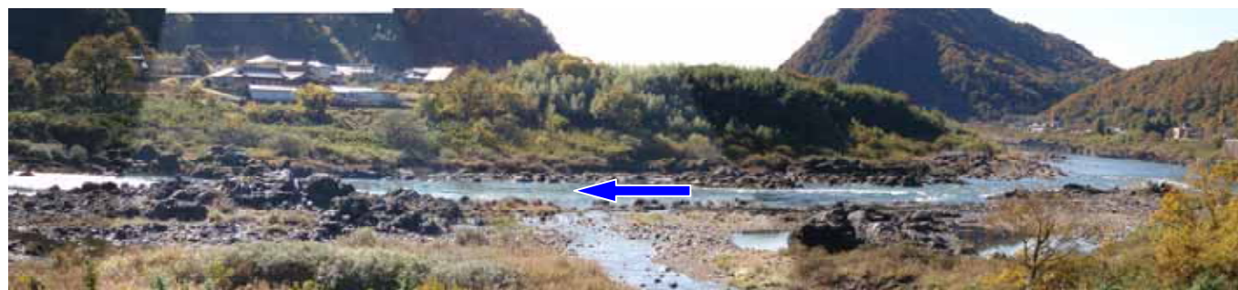
放水施設予定区域における重要な地形・地質の状況（上流側より撮影）
