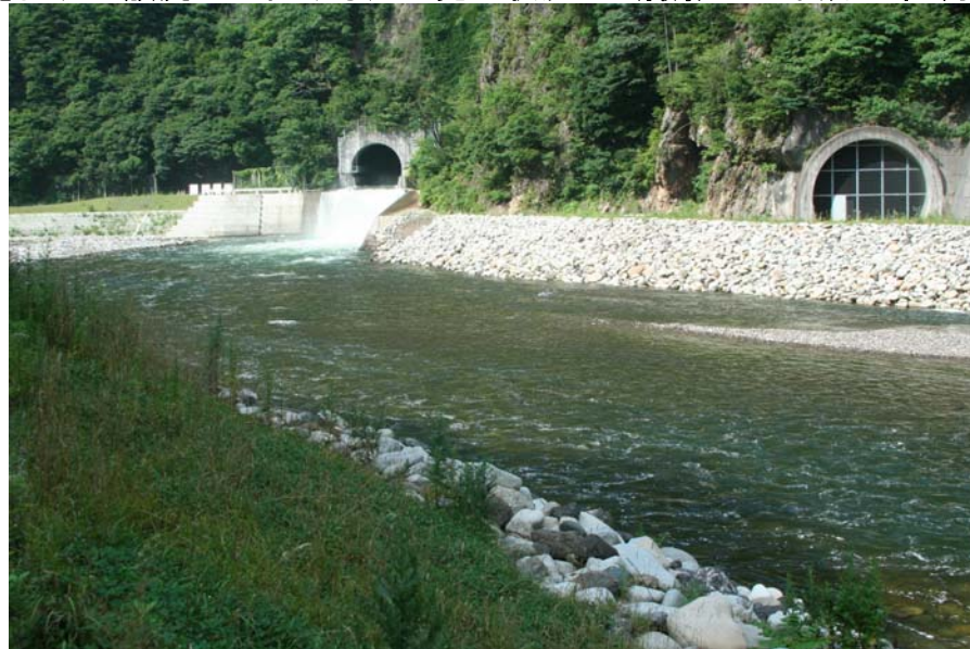
徳山ダム放流口における泡の発生状況 (撮影日：平成20年8月1日)
