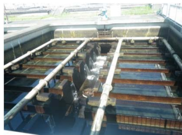
急速ろ過装置
