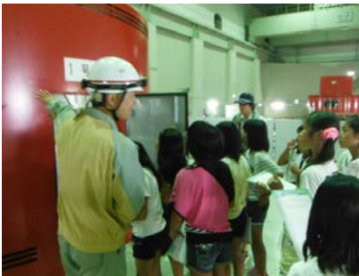
馬瀬川第1発電所
