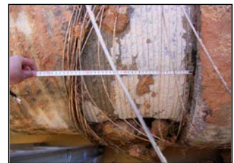
破裂したPC管
