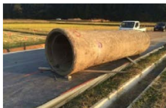
撤去したPC管
