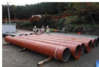
搬入された新管(ダクタイル鋳鉄管)
