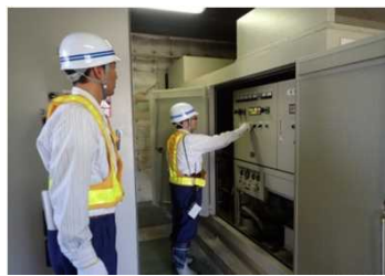
電気設備の点検訓練
