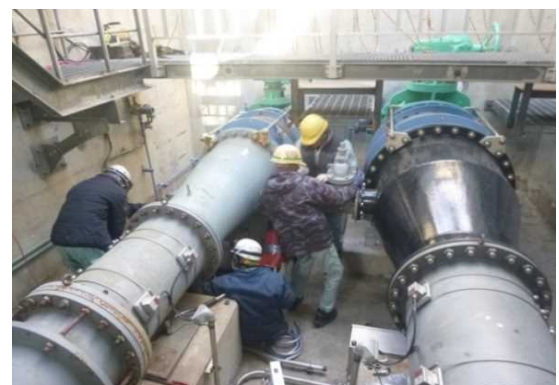
ピット内配管
