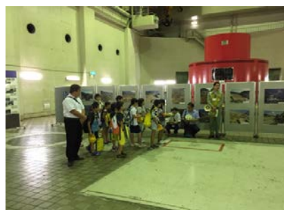
馬瀬川第二ダムの地下発電所
