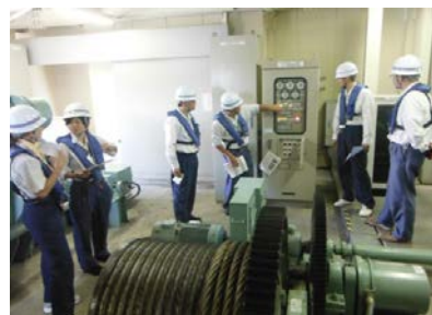
堰開閉装置点検
