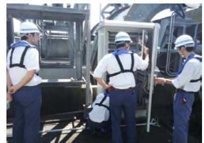
海部幹線除塵施設点検
