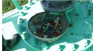
水管橋の都市用水空気弁清掃
