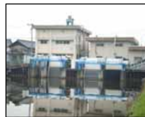
地区内排水をする近 江島排水機場
