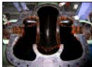
開放後の下部ケーシング
