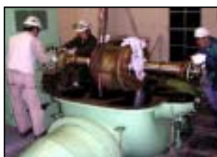
羽根車・主軸等取外
