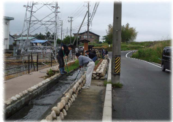
せせらぎ水路の清掃活動状況
