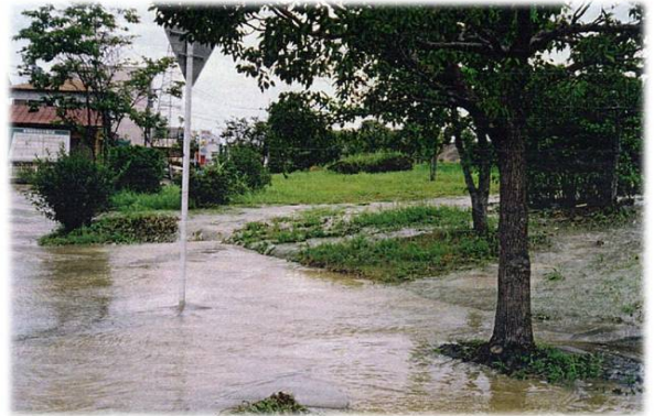
長島支線FRPM管 H14年度の出水の様子
