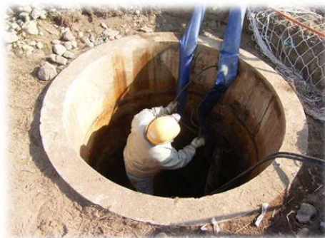
ポンプ排水の状況
