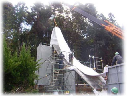
管更生工法 インシチュホーム工法 L=約146m 施工状況(遠景)
