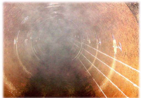
調査箇所へのマーキング
