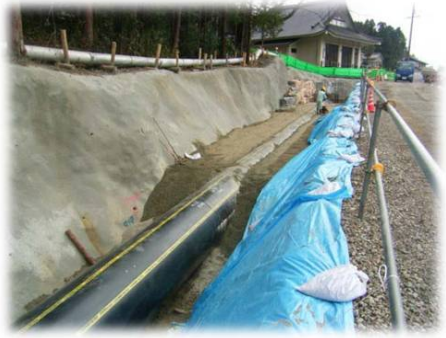
埋戻し状況 素堀区間(鋼管φ1,100mm)
