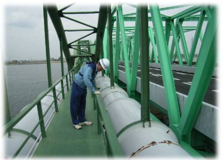
木曾川水管橋点検状況 (右に見えるのは東名阪道)
