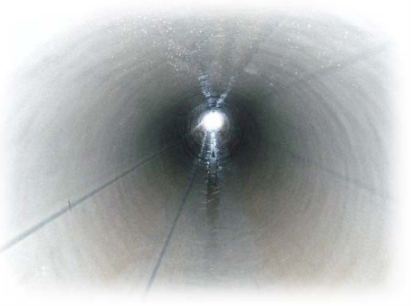
管更生工法 インシチュホーム工法 L=約146m 施工完了 管内状況
