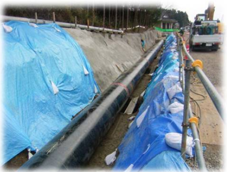
鋼管布設状況 素堀区間(鋼管φ1,100mm)
