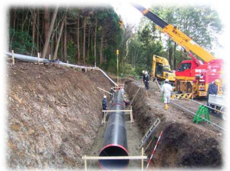
鋼管布設状況 素堀区間(鋼管φ1,100mm)
