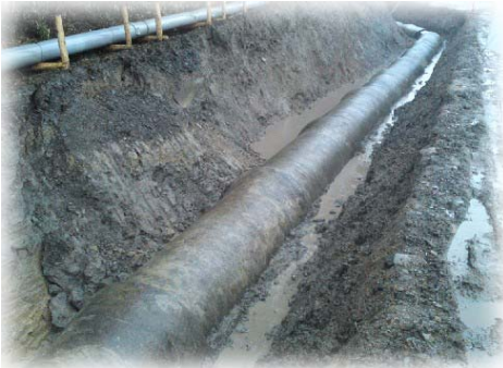
既設PC管埋設状況
