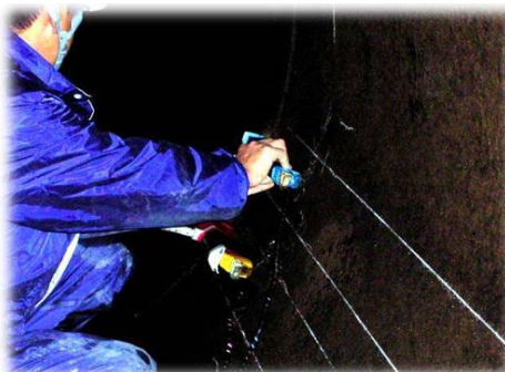
機器による調査状況
