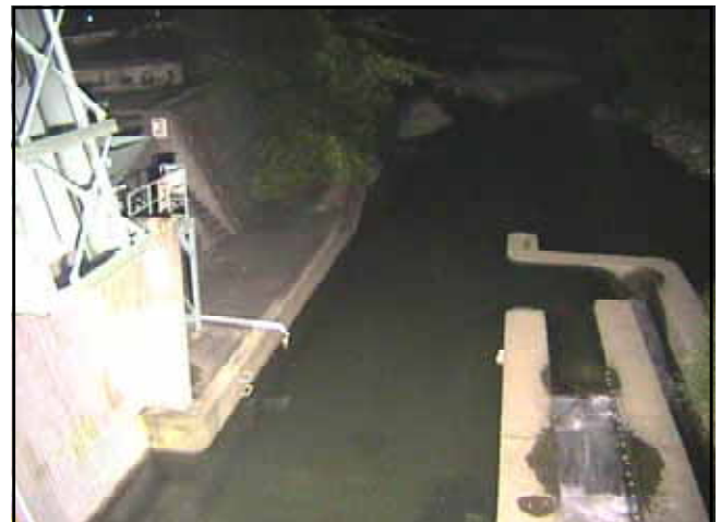
図-18 夜間の監視カメラ映像（牧田川取水工）
