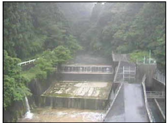
図-17 日中の監視カメラ映像（河内谷川取水工）
