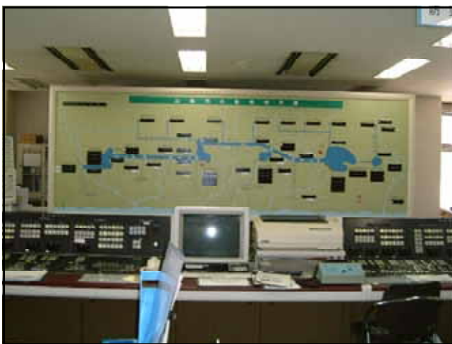
図-5 グラパネと操作卓（左;更新前）と端末装置群（右;更新後）
