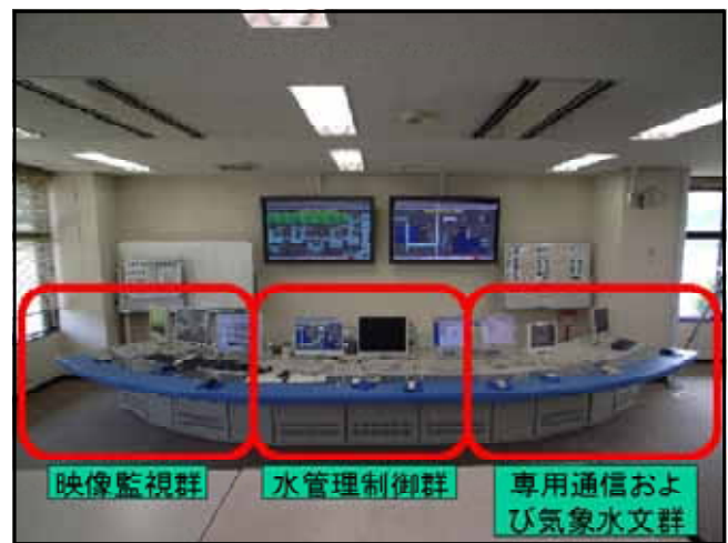
図-5 グラパネと操作卓（左;更新前）と端末装置群（右;更新後）
